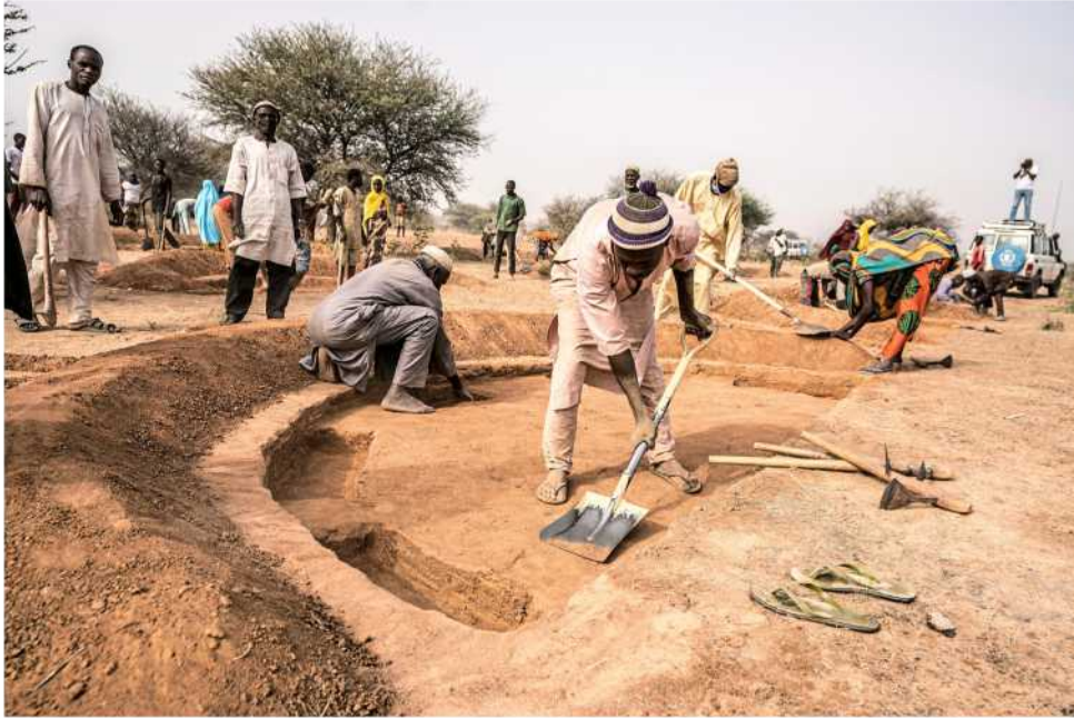
Arbeiter bei Bau eines Wasserrückhaltebeckens in Niger: »Ökologisches System wieder anwerfen«
